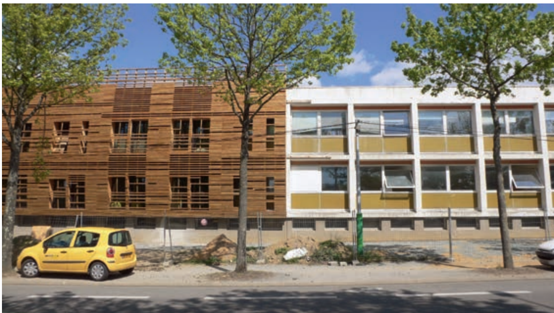
Réhabilitation du Centre de formation des Compagnons du Devoir du Tour de France à Angers. Remplacement des murs rideaux menuisés par des façades ossature bois courbes, permettant le passage des réseaux entre structure béton et façade rapportée | Architecte : SNAP Architecture Entreprise : ACB | ©SNAP Architecture
